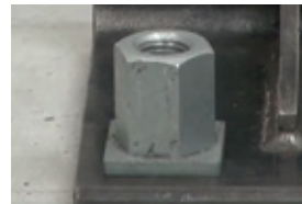
③ロングネジナット本体をセットし、トルクレンチで規定値まで締め込みます。
